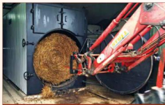
Nowoczesny piec w kotłowni „Eko-Bug” opalany słomą
