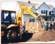
Budowa sieci wodociągowej
